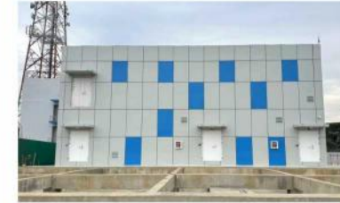
数据中心 DATA CENTER
